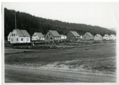
Fig.41. Bergsgatan ca 1960 (BDB).
