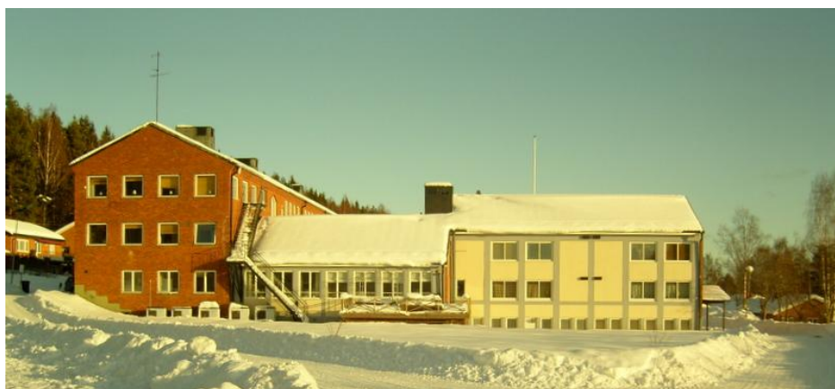
Fig.16. Remsle skola byggd 1957. Foto: Jan Molander.
